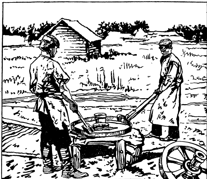
Рис. 1. Обтягивание колеса шиной.
